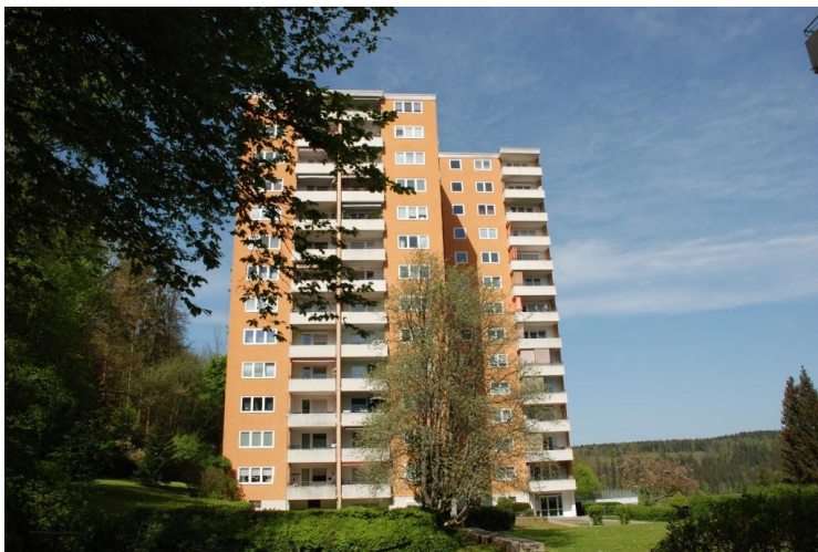
(2) Ansicht Ost mit Hauseingang
