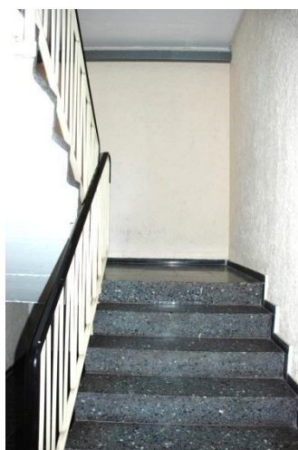
(18) Treppe zum UG
