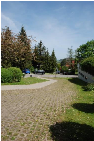
(6) Zufahrt zum Hauseingang auf der Ostseite
