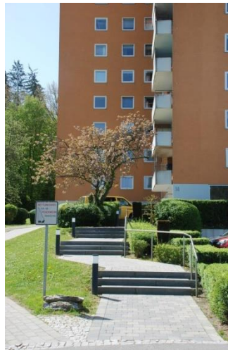
(7) Treppe zum Hauseingang
