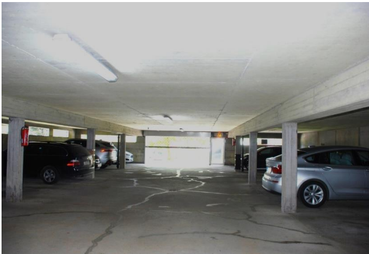
(21) Tiefgarage mit Rollgitter
